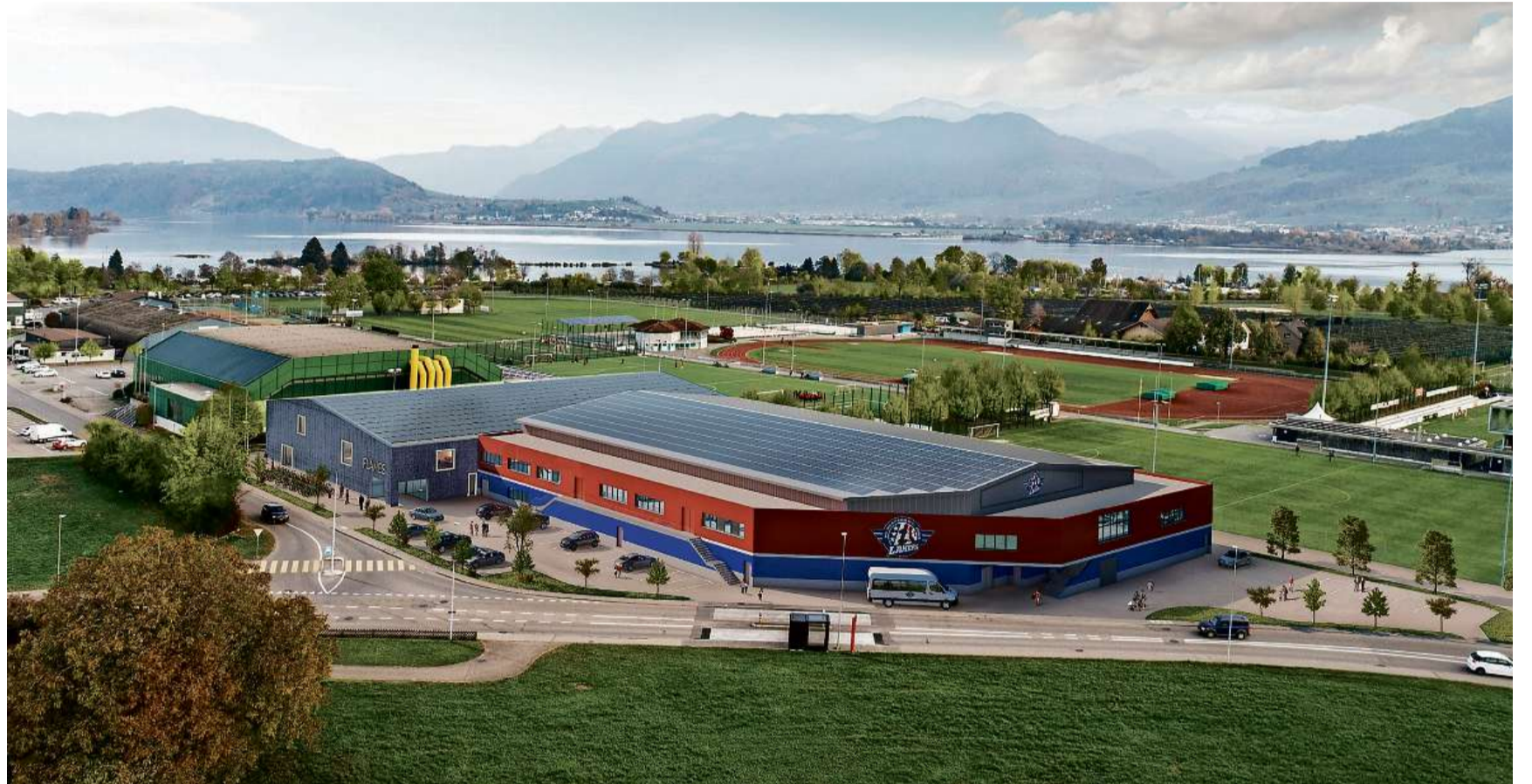
Prognosen zum Zeitplan schwierig: Bis die Flames-Arena und die Trainingshalle der SCRJ Lakers Seite an Seite im Grünfeld stehen, könnte es länger als gedacht gehen.
