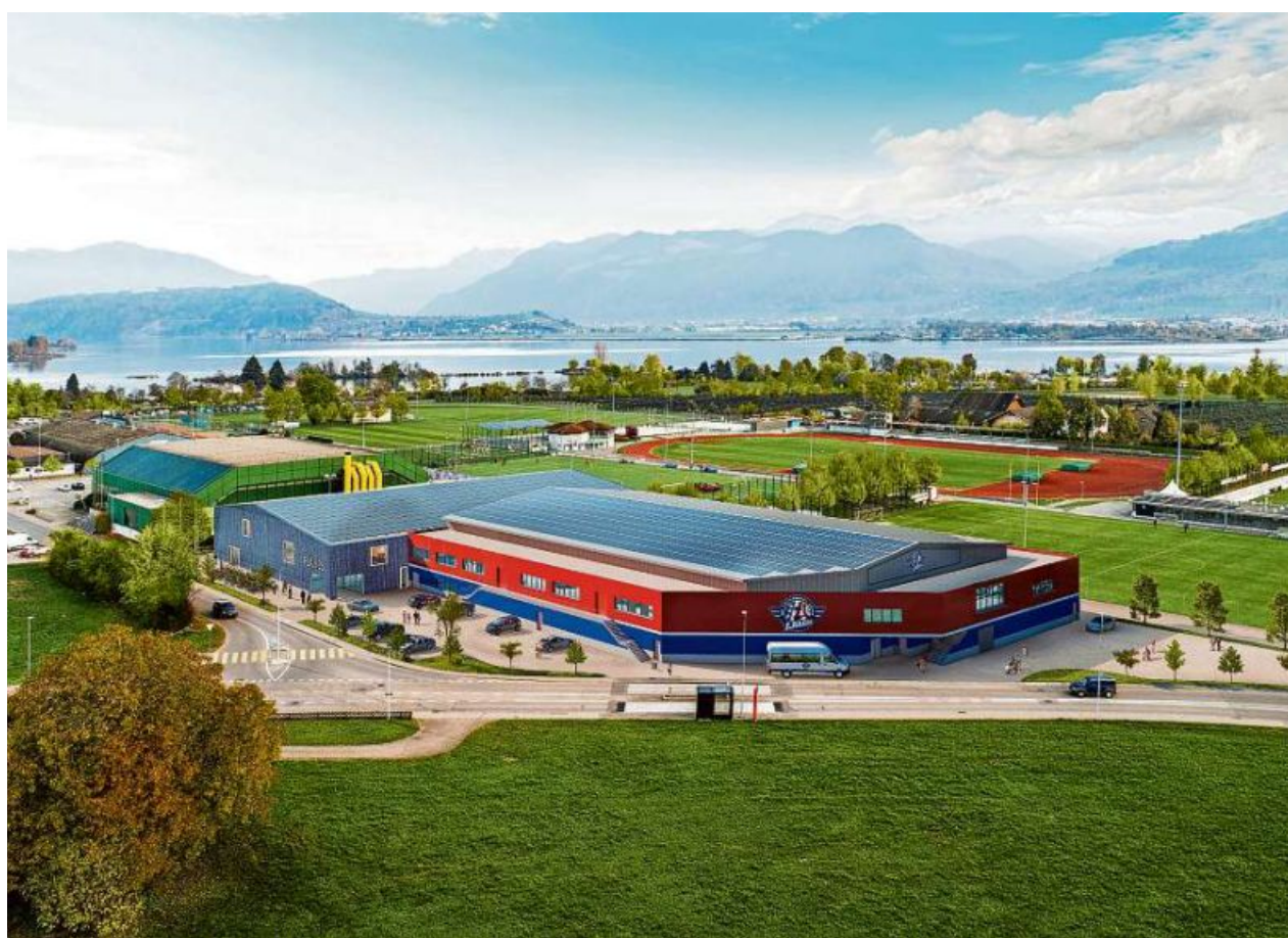
Es kommt wohl nur ein Teil: Die Jona-Uznach Flames können den Bau ihrer Unihockeyhalle im Grünfeld (Mitte) definitiv in Angriff nehmen – eine Realisierung der Trainingshalle der Lakers (rechts) scheint unwahrscheinlich.
